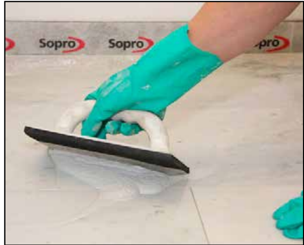
2 Het voegen van verkleuringsgevoelig natuursteen met Sopro DF 10®.
