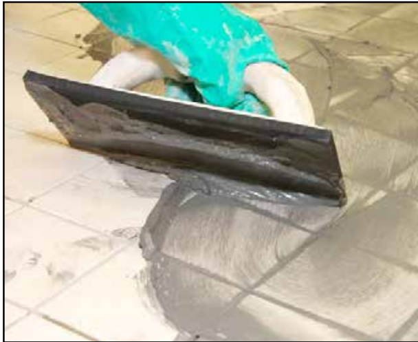
1 Het voegen van tegels met een zeer lage wateropname met Sopro DF 10®.
